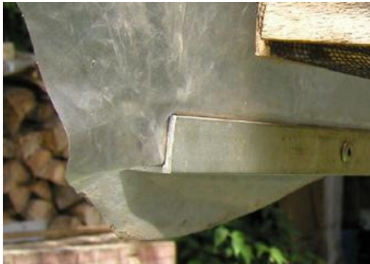
Fig 8 : Winkelprofil auf der Unterseite
