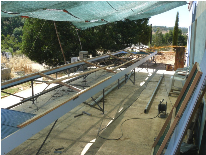
Bau des Grundgestells: 12m lang, 2m breit, 60-105cm hoch
