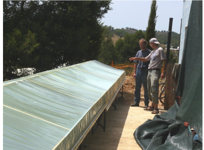
Der Boden wird innen schwarz gestrichen, darüber kommt die transparente Folie
